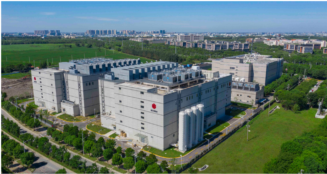
万国数据昆山数据中心
