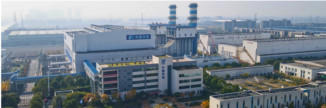
华电国际发电设施
